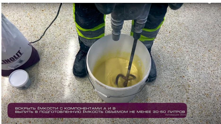
2. Постепенно внести наполнитель (компонент С) в смесь, мешать в течение минимум 3 минут до полного перемешивания и получения гомогенной (однородной) смеси. Рекомендуемое время смещивания 2-3 минуты. Особое внимание следует уделять тщательному перемешиванию материала в зоне дна и стенок ведра во избежании дефектов покрытия (плохо перемешанные
